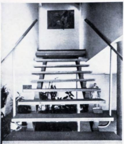
*La scala di accesso alla casa è in struttura di acciaio con gradini e pianerottolo in granito grigio brasiliano. Le parti in muratura e cemento sono intonacate e dipinte in bianco; i tubi Mannesmann, gli infissi e la struttura portante della scala sono grigio chiaro, i due doccioni e le pareti di ferro, rosso fuoco. In cima alla scala: mosaici di de Chirico e una statua greca del V secolo. Nella foto a destra: vasca con ninfee e pesci, strada in arenaria rosa ad opus incertum.*
